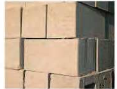
el bloque de hormigón cinder block
