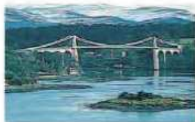
el puente bridge
