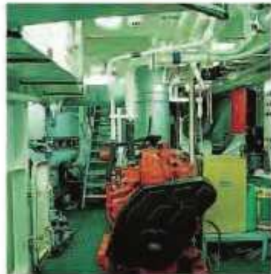
la sala de máquinas engine room
